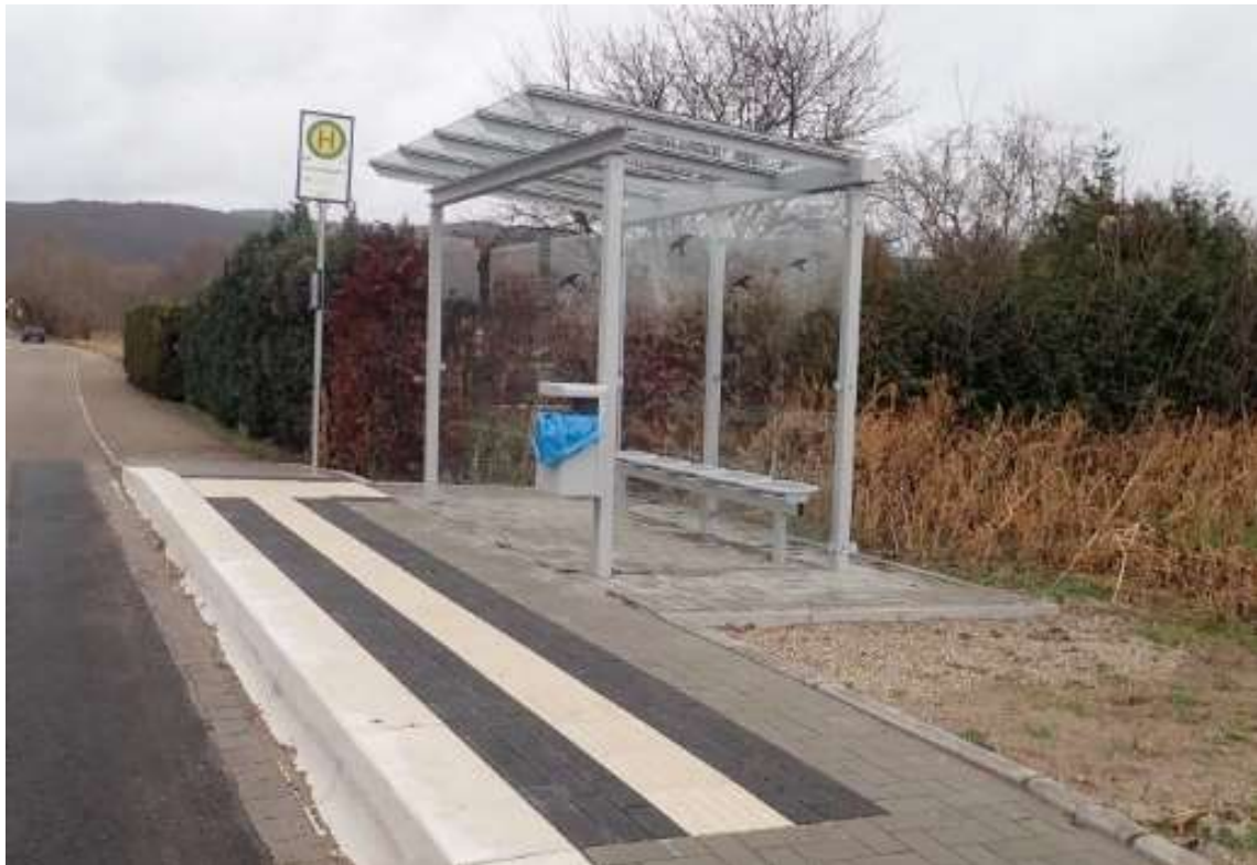
Umgebaute Bushaltestelle in der VG Deidesheim
