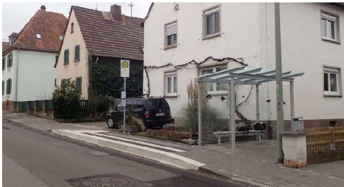
Umgebaute Bushaltestelle in der VG Deidesheim
